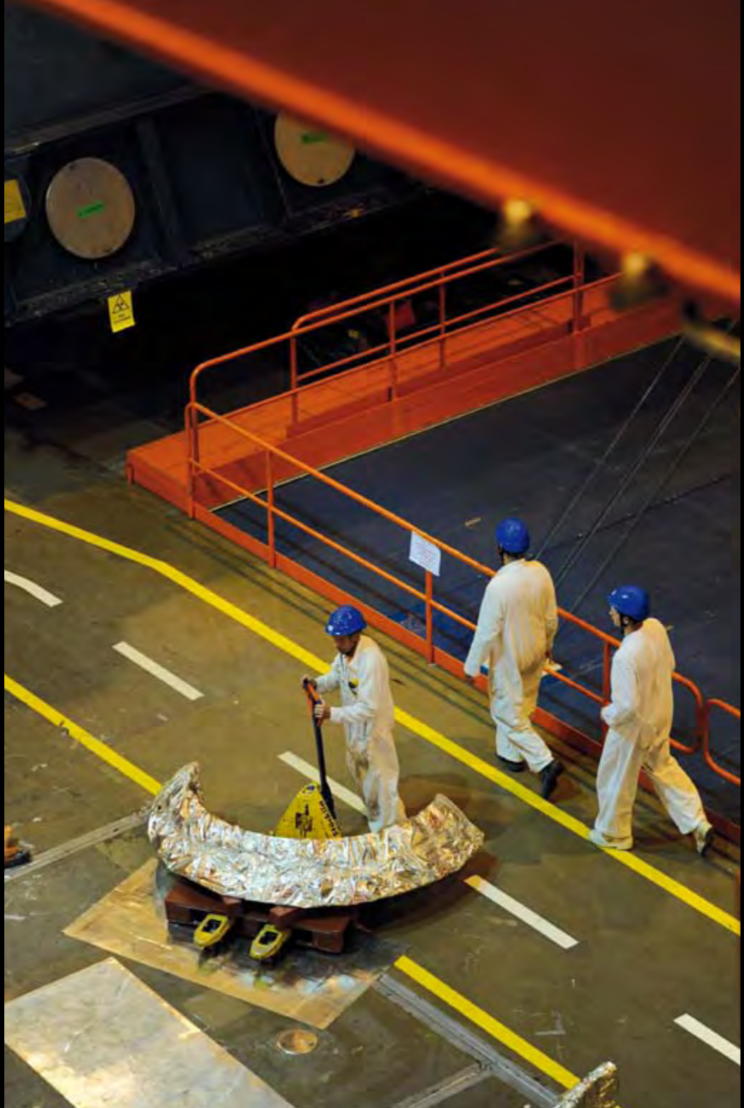
Blick vom Maschinenhauskran auf die Montagearbeiten der Niederdruckturbinen.
