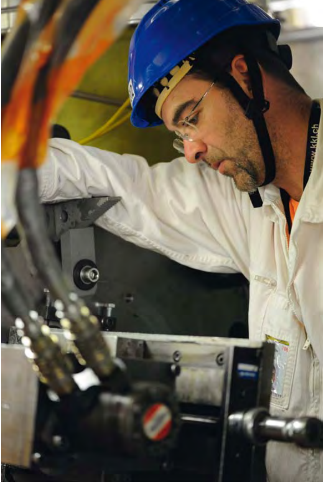
Ein Gewinde in einer Speisewasserpumpe wird überarbeitet. Das ist eine von unzähligen Arbeiten, damit das Kernkraftwerk nach der Revision wieder sicher und zuverlässig läuft.
