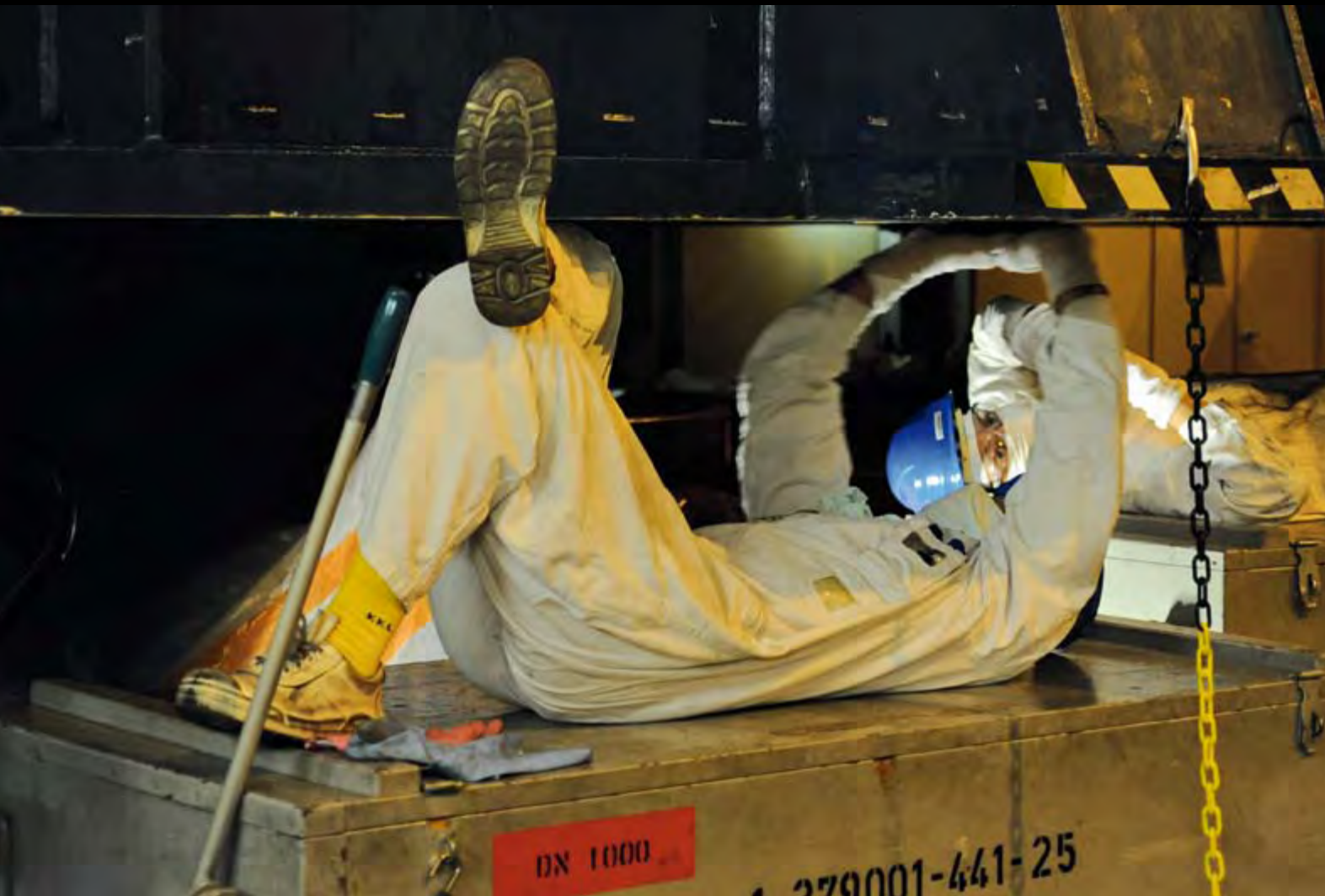
Das Schleifen der Dichtflächen der Turbinen-Aussengehäuse ist einer der zahlreichen Schritte beim Austausch der Niederdruckturbinen.
