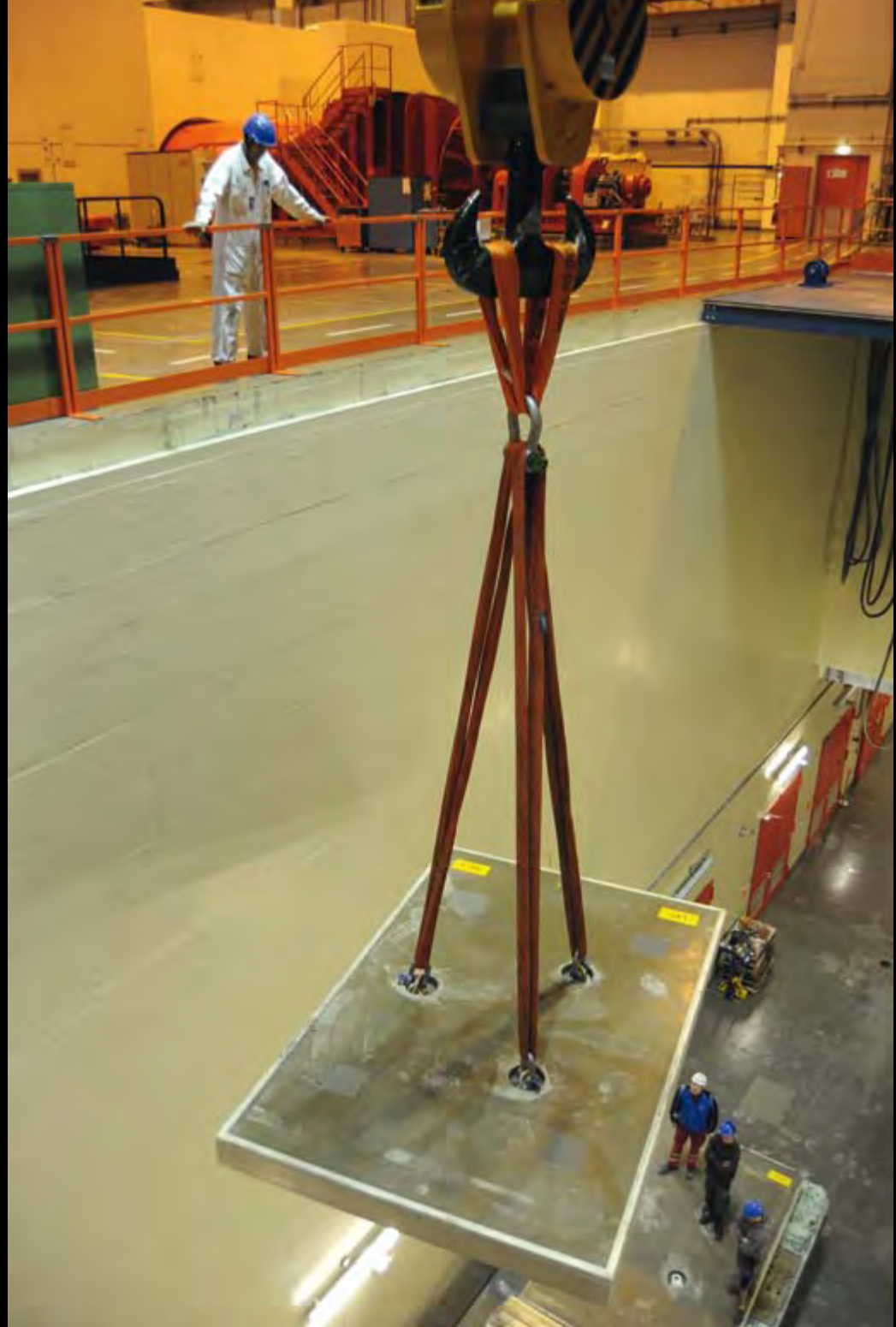
Die tonnenschweren Abdeckplatten für die Transport-Luken im Maschinenhaus werden gegen Revisionsende wieder montiert.
