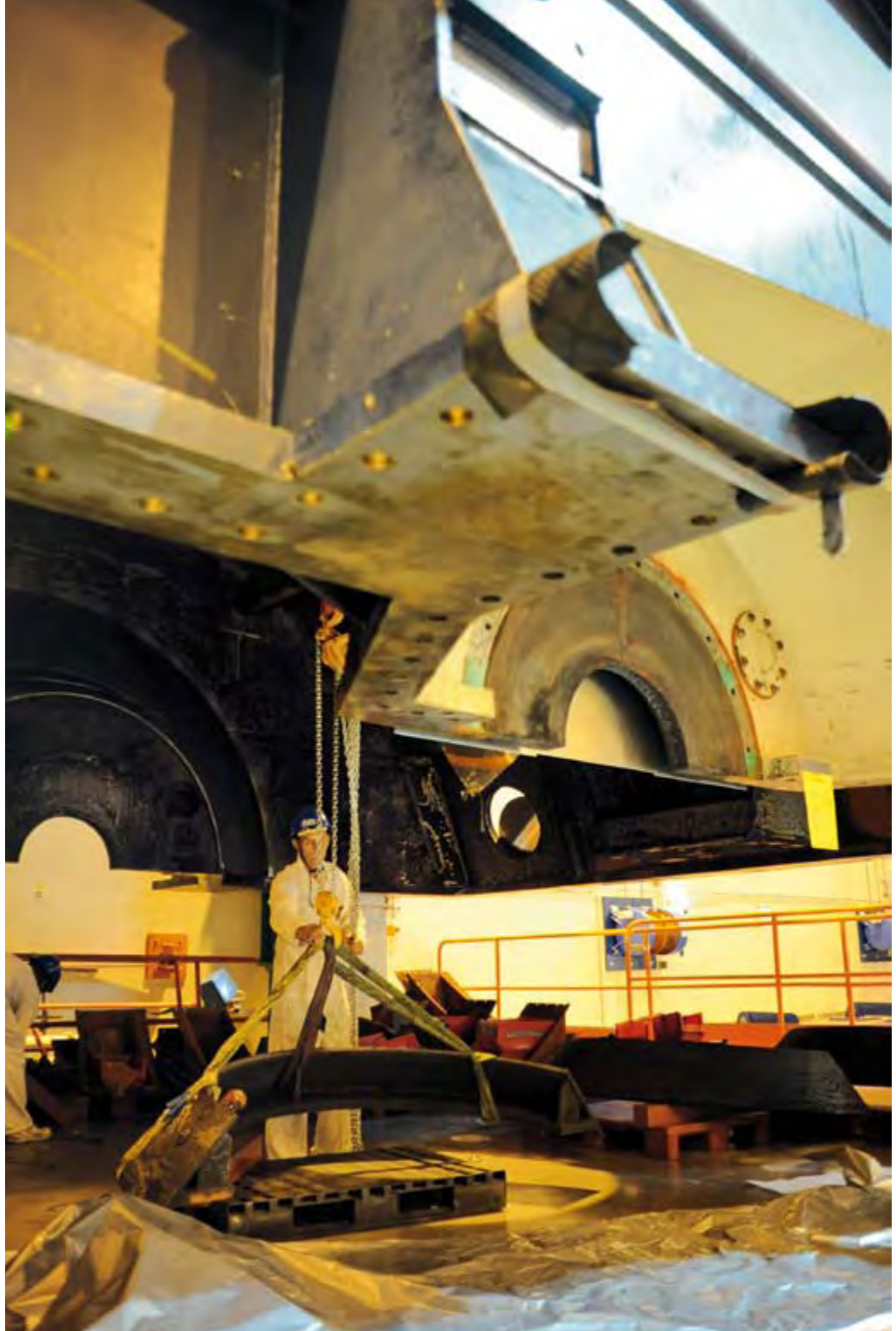
Für die Revisionsarbeiten an den Niederdruckturbinen wurden die Turbinen-Aussengehäuse entfernt und in unmittelbarer Nähe abgesetzt.
