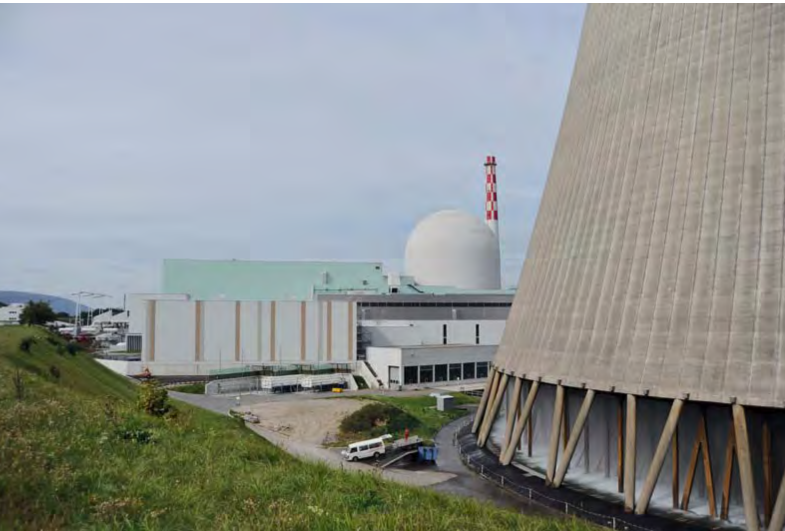
Die neu errichtete Lagerhalle mit gestreifter Fassade bietet Platz für Grosskomponenten wie Niederdruckturbinen und -vorwärmer.
