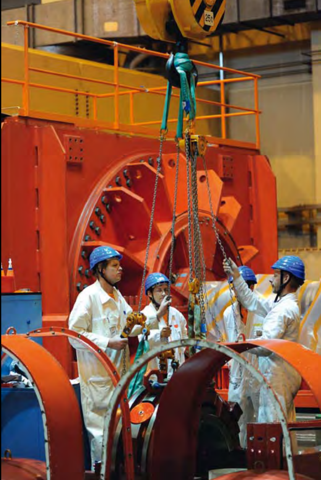
Teile der Generatorverkleidung werden mit dem Kran verschoben.
