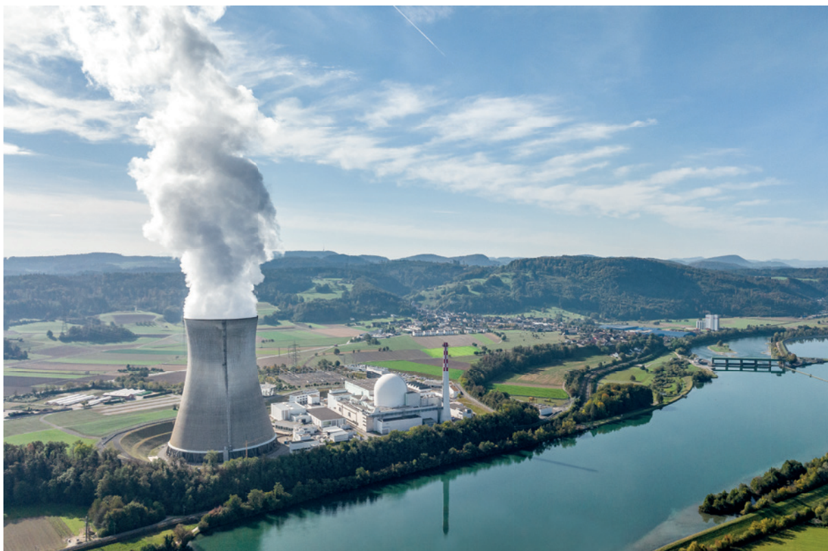
Bis mindestens 2045 will das Kernkraftwerk Leibstadt Strom für zwei Millionen Haushalte produzieren.
