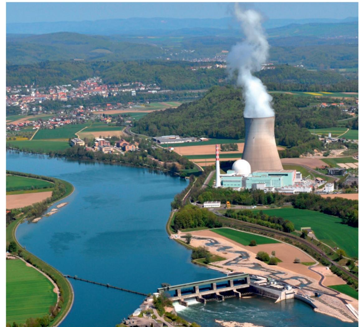
Dank der Kühlung über einen Kühlturm sind die Wasserentnahme aus dem Rhein und der Wärmeeintrag praktisch nicht spürbar.
