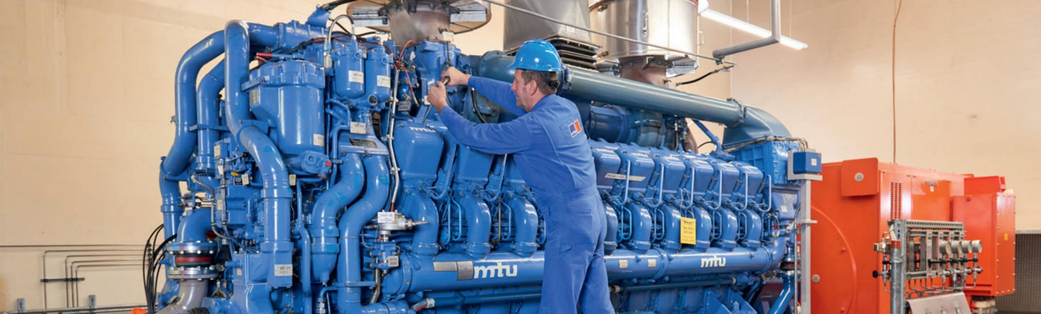
Alle drei 20-Zylinder-Motoren der Notstromdieselgeneratoren verfügen jeweils über 6250 PS.
