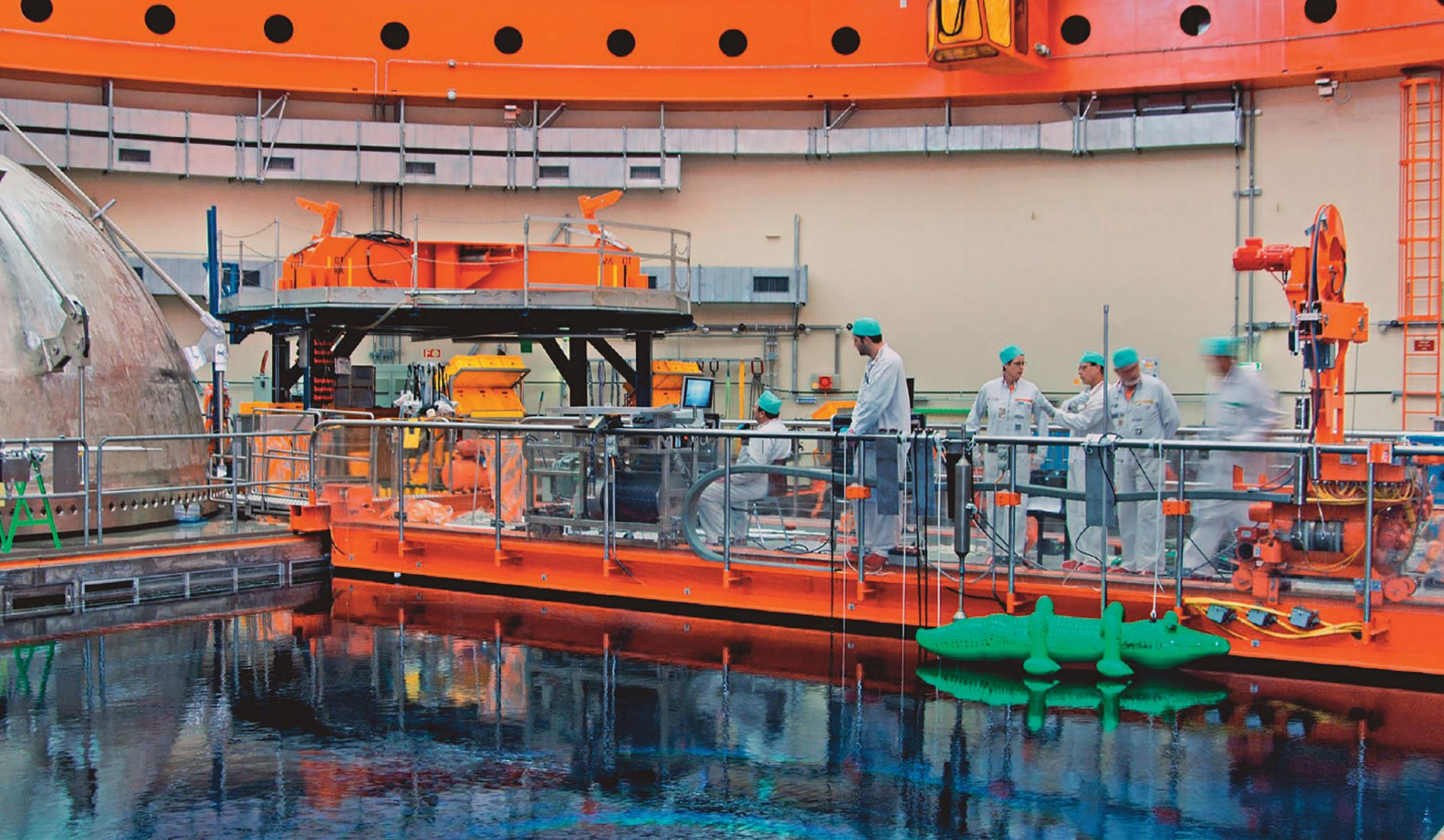
Bei Revisionsarbeiten macht das aufblasbare Krokodil den Wasserspiegel des kristallklaren Reaktorwassers gut sichtbar – eine einfache und wirksame Sicherheitsmassnahme.
