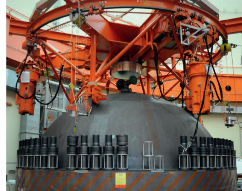
Mit einem Spezialkran wird bei der Jahreshauptrevision der Deckel des Reaktordruckgefässes abgehoben.
